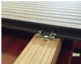
Upevnenie dosky k nosníku
